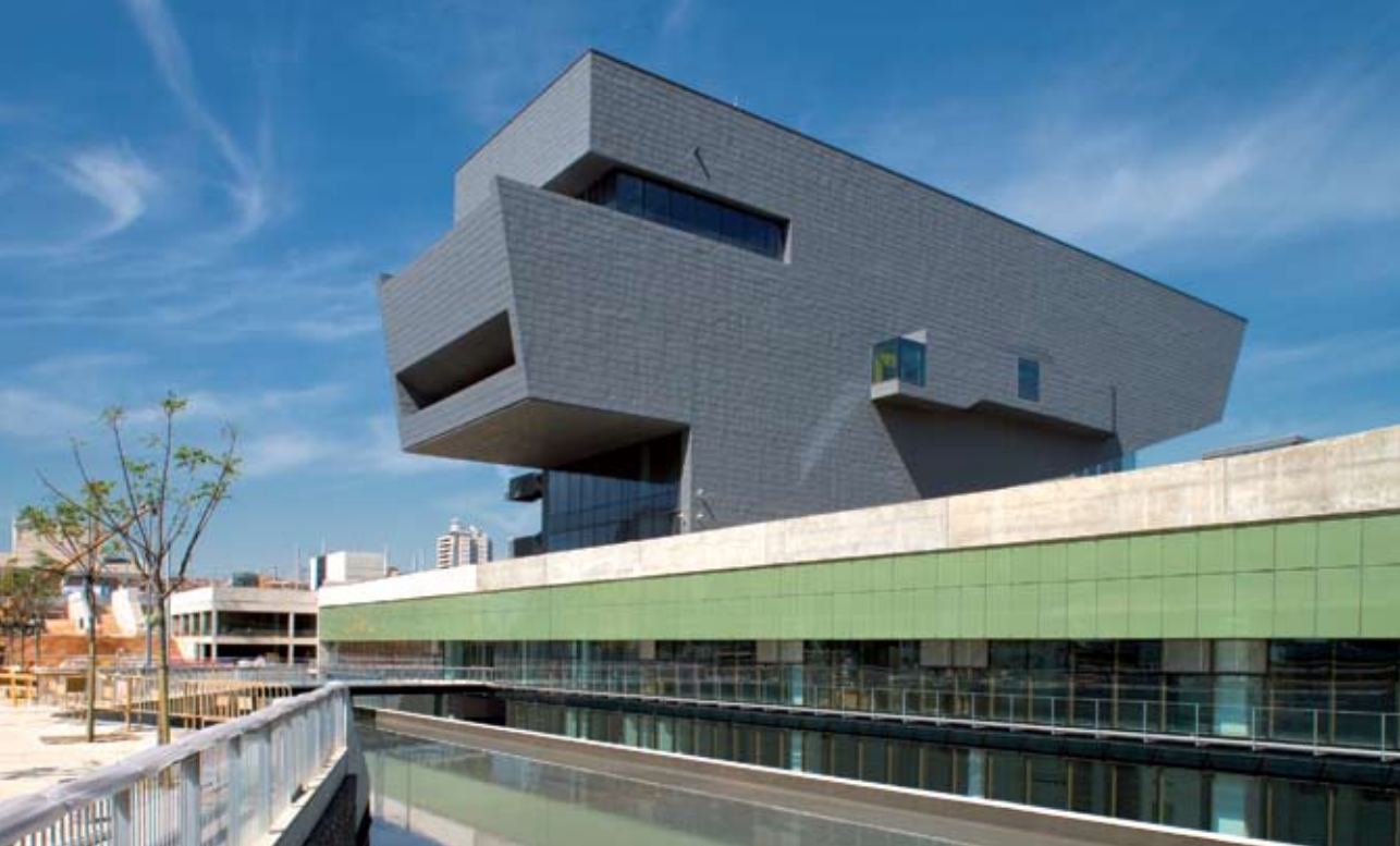
Edifici DHUB. Fotografia: Lourdes Jansana
