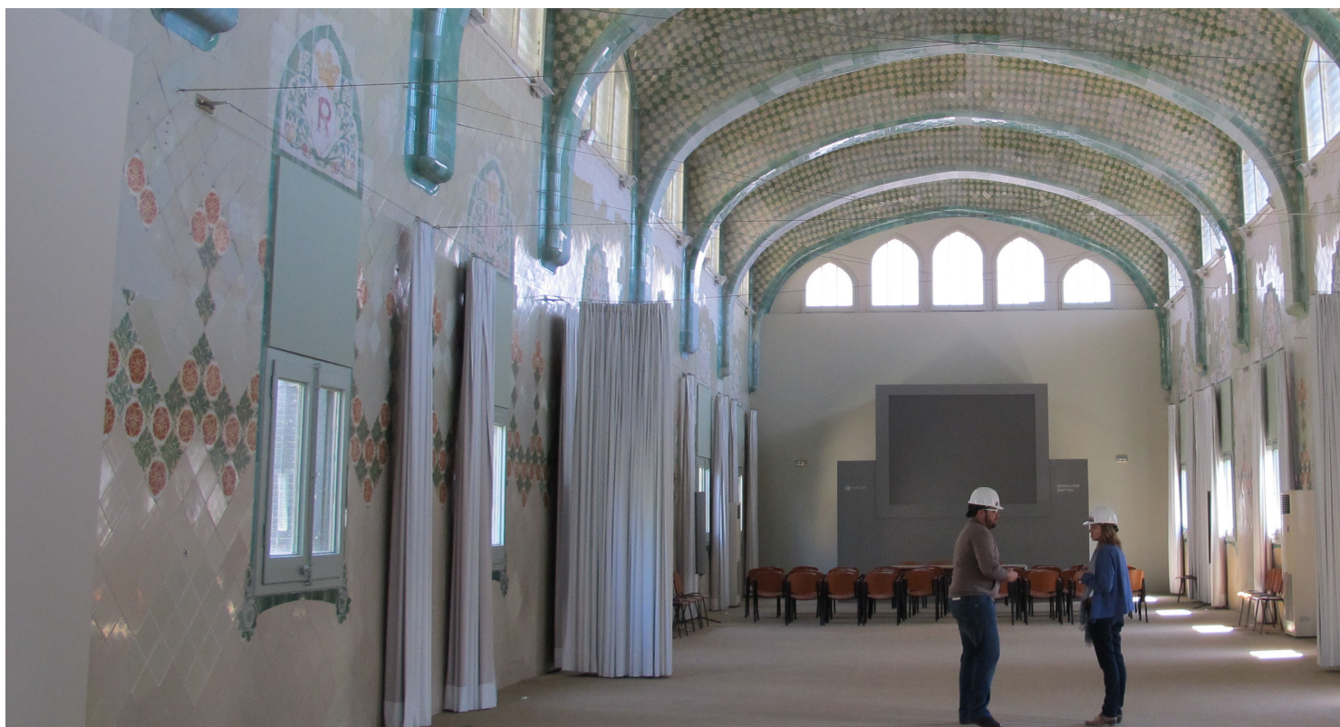
Obres de restauració de l'Hospital de Sant Pau de Barcelona.
